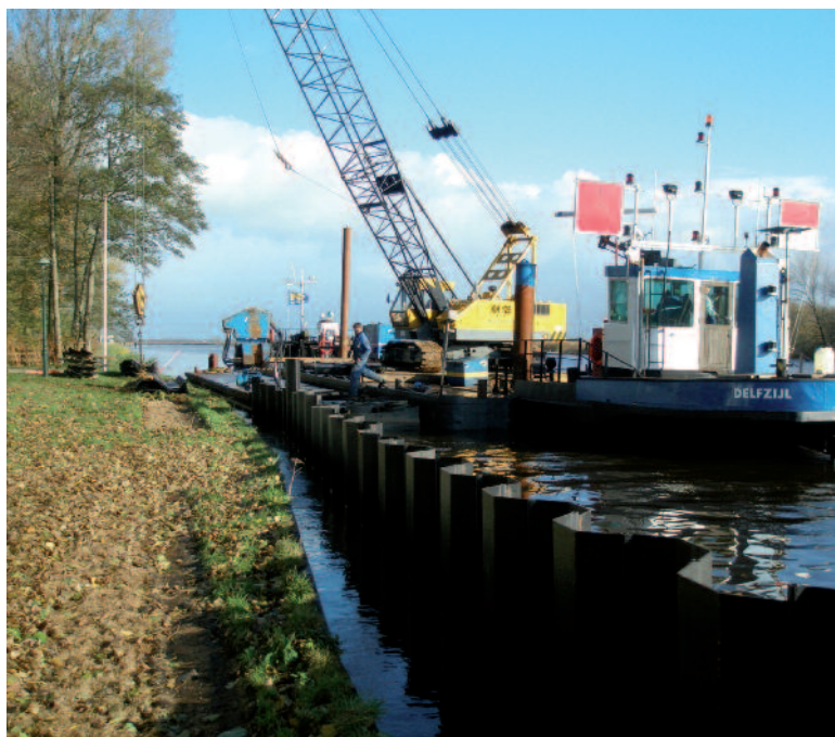
Aanbrengen stalen damwand Prinses Margrietkanaal
